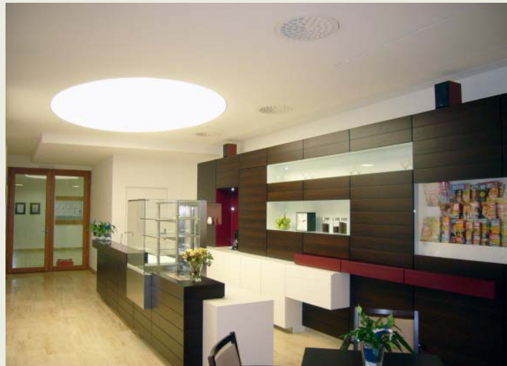
3 Für matte Spanndecken lässt sich der Reflexionsgrad für das Licht vorher bestimmen. In dieser Praxis wurde außerdem ein runder „Lichtkasten“ in die Decke integriert.
